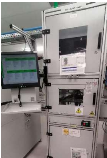
Ilustración 16: Estación de prueba de voltaje
